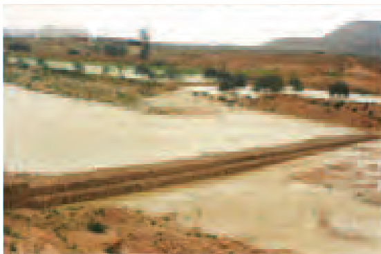
Ouvrages de recharges des nappes en Tunisie
