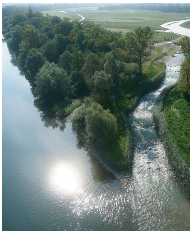
Vue aérienne de la renaturation du Rhin
