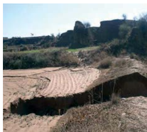
Avant-après le contrôle de l'érosion
