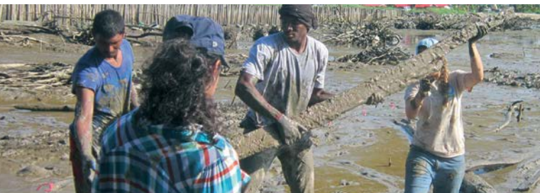
Construction d'unités de piégeage des sédiments
