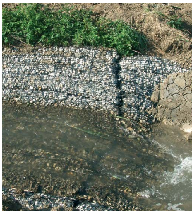
Utilisation de gabions tubulaires liés entre eux, remplis avec des matériaux pierreux identiques au cours d'eau. Couverture du fond du lit et des berges
