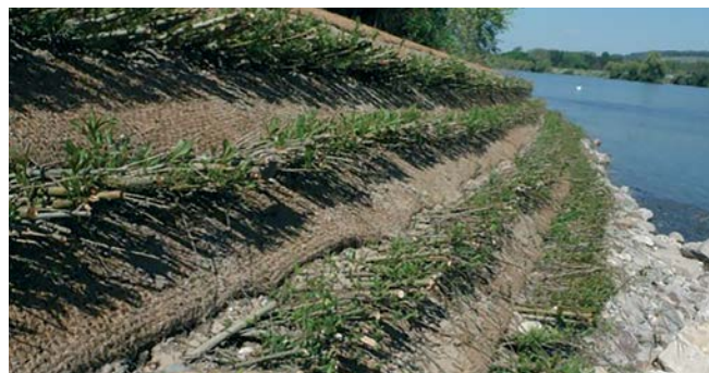
Lits de plants et plançons en protection de berges
