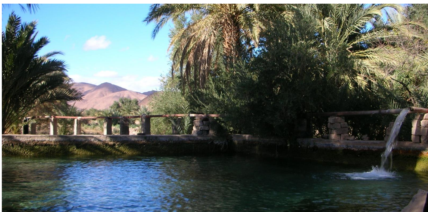
Un bassin de stockage
